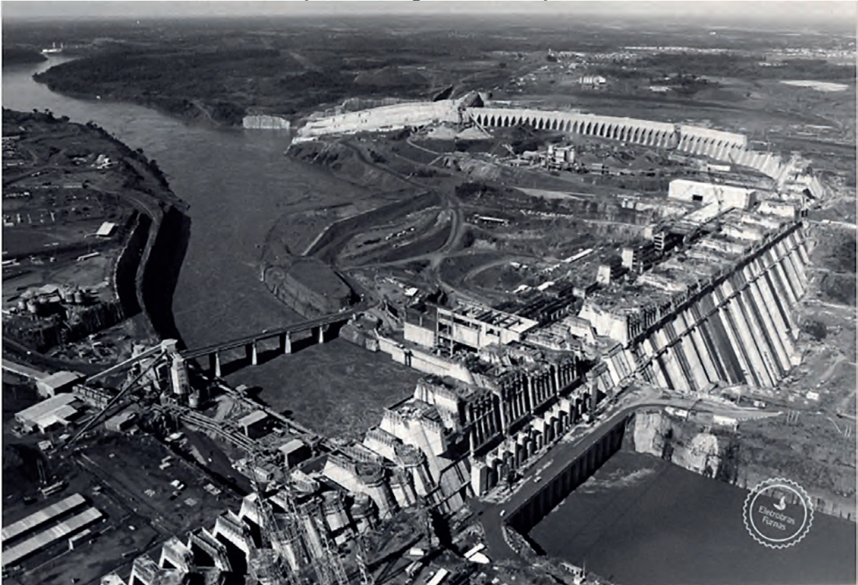
Figura 19: Itaipu em construção. Destruição do espaço sagrado Guarani. “Imagens aéreas de construção da Usina Itaipu Binacional, com construção da barragem de concreto, vertedouro, casa de força, condutos forçados e vista geral da construção”
